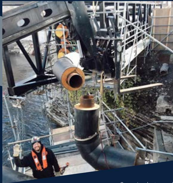
Connexion des tuyaux du système d'énergie thermique
