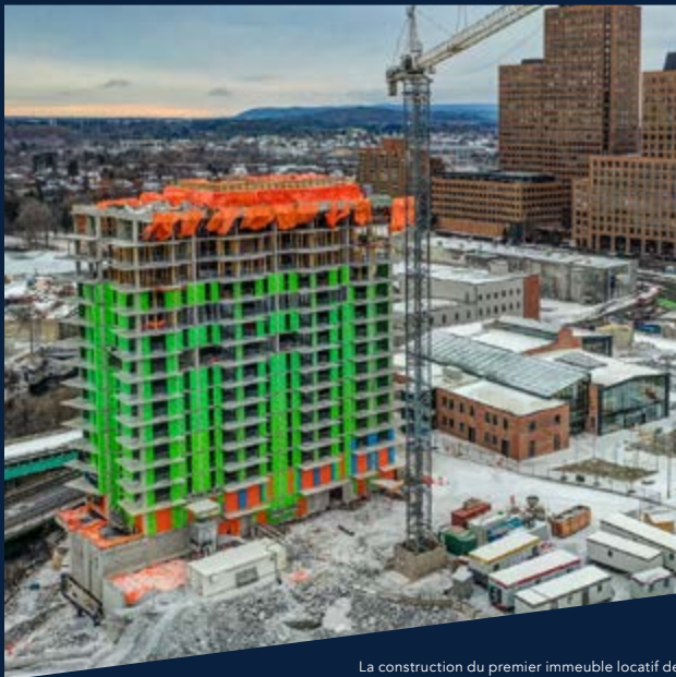
La construction du premier immeuble locatif de Zibi a débuté à l'intersection des rues Eddy et Jos-Montferrand à Gatineau.
