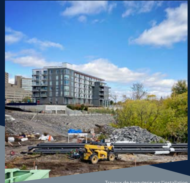
Travaux de tuyauterie sur l'installation permanente du système d'énergie de quartier dans le sous-sol du bloc 10.
